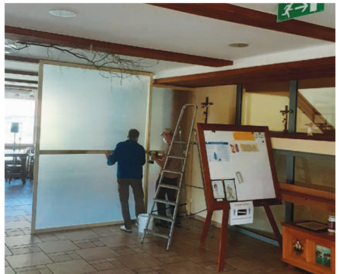
Andrej in Miran pripravljata razširitev rdeče cone v domsko avlo.
