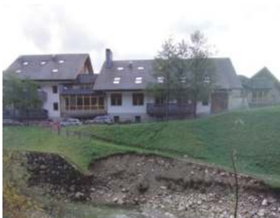
Narasla Ribnica je jeseni odnesla del brežine pod Domom.
